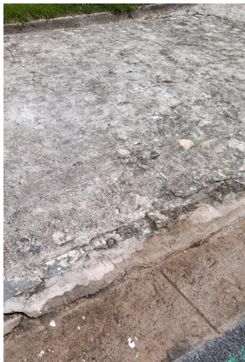
Lavagem dos passeios e paredes do Parque Fabril
